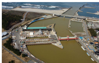
新川河口排水機場 新潟県新潟市
